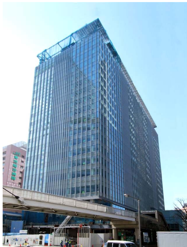
工事進捗状況(2月中旬時点)
