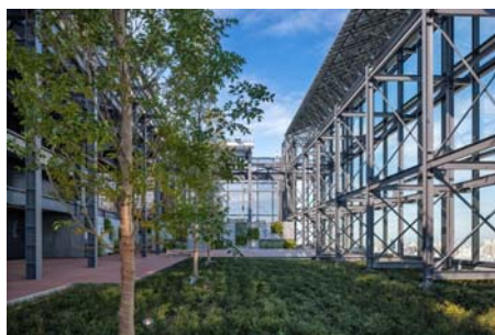
< 屋上緑化 > 建物が受ける熱負荷を抑制
